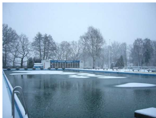
SV Poseidon, Beckensanierung
