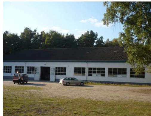
Segelflug-Club Fischbek, Sanierung Elektroanlage
